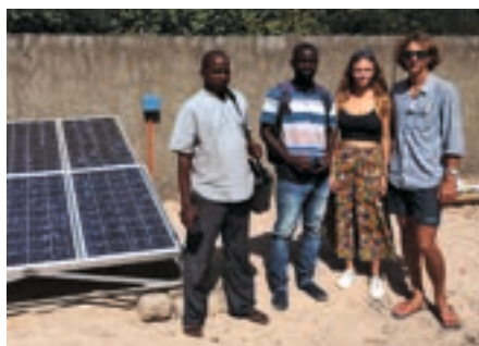
Mission accomplie. Elaï, Charles, le proviseur et un enseignant du collège de Falia présentent la nouvelle installation électrique de l'établissement.
